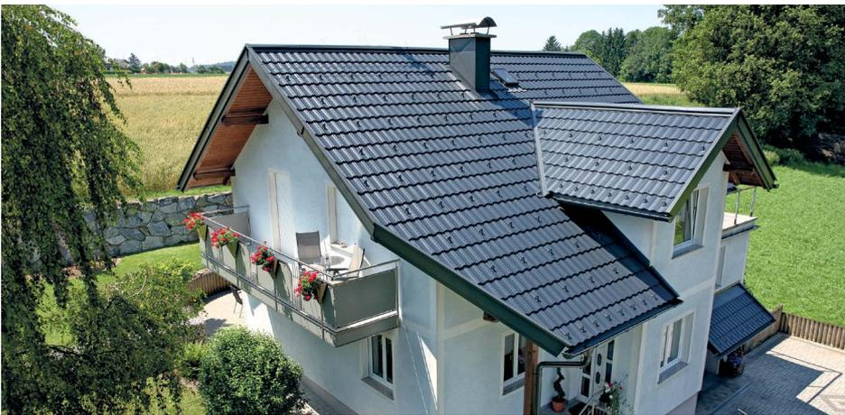
Bei der DECRA ELEGANCE ACO werden aus zwei Metallschichten in der Stärke von 0,3 mm in einer besonderen Technik laminiert. Hierbei wird eine lärmabsorbierende Schutzschicht eingearbeitet, welche die Akustik des Elements enorm verbessert. Die Oberfläche besteht aus einer extrem hochwertigen und resistenten Pulverbeschichtung welche kratzfest und Ultra UV- Beständig ist. Die Aluzink Beschichtungsmasse beträgt hierbei 150 g/m<sup>2</sup> bzw. 250 g/m<sup>2</sup> aus Zink Magnesium.
